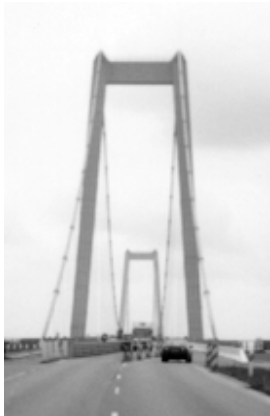
De hangbrug over de Rijn bij Emmerich. De kabels waaraan het wegdek hangt hebben de vorm van een parabool.
