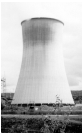
Een koeltoren aan de Maas bij Hoei (België). De vorm is die van een omwentelings-hyperboloïde.
